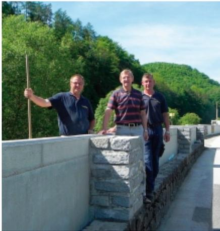
Vom Magdalenensteg bis zur Krankenhausbrücke wurde die bestehenden Mauer erhöht bzw. sind Schutzmauern neu errichtet worden. Beton-Fertigelemente wurden aufgesetzt. Die Zugänge zum Strandweg werden mit mobilen Elementen, welche in der Strangpresse in Marktl erzeugt werden, gesichert. Das System bewährte sich im Mai 2014 bei Hochwasser.
