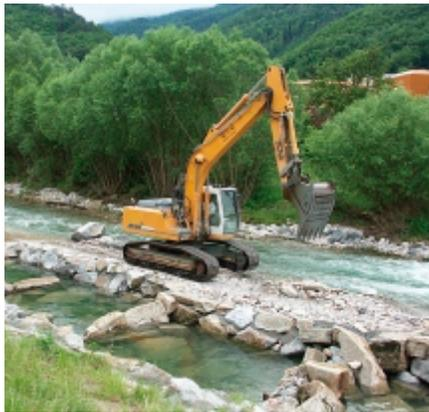
Das Tosbecken bei der Krankenhausbrücke wurde abgetragen. Die Traisen wurde eingetieft und verbreitert. Für die Organismen wurde in die Traisen eine Aufstiegshilfe mit Tümpeln eingebaut.
