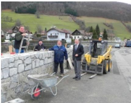
In Schrambach wurde von der Morigrabenbrücke flussabwärts die bestehende Natursteinmauer erhöht. Auch diese Maßnahme führte zu erhöhter Sicherheit in Schrambach wie der Mai 2014 zeigte.
