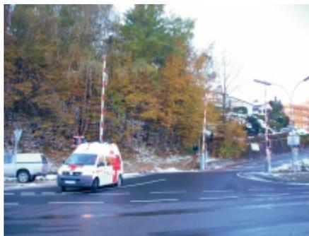
Durch die Modernisierung der Strecke war die Errichtung einer Schrankenanlage bei der Auffahrt zum Landeskrankenhaus Voralpen möglich. Die Schließzeit der automatischen Anlage ist kurz. Dies ist für den Notarztwagen wichtig. Die Anlage ist mit zusätzlichem Rotlicht und Verkehrszeichen gesichert.
